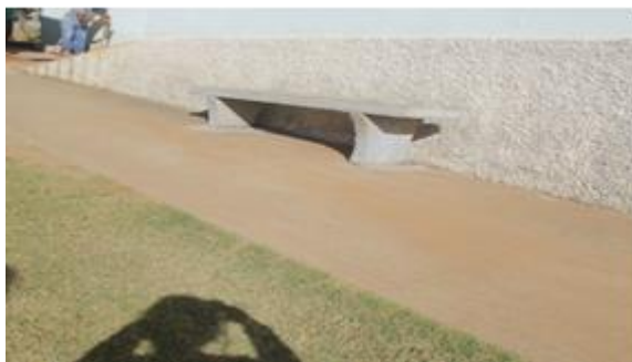
Figura 23 - Banco de cimento
