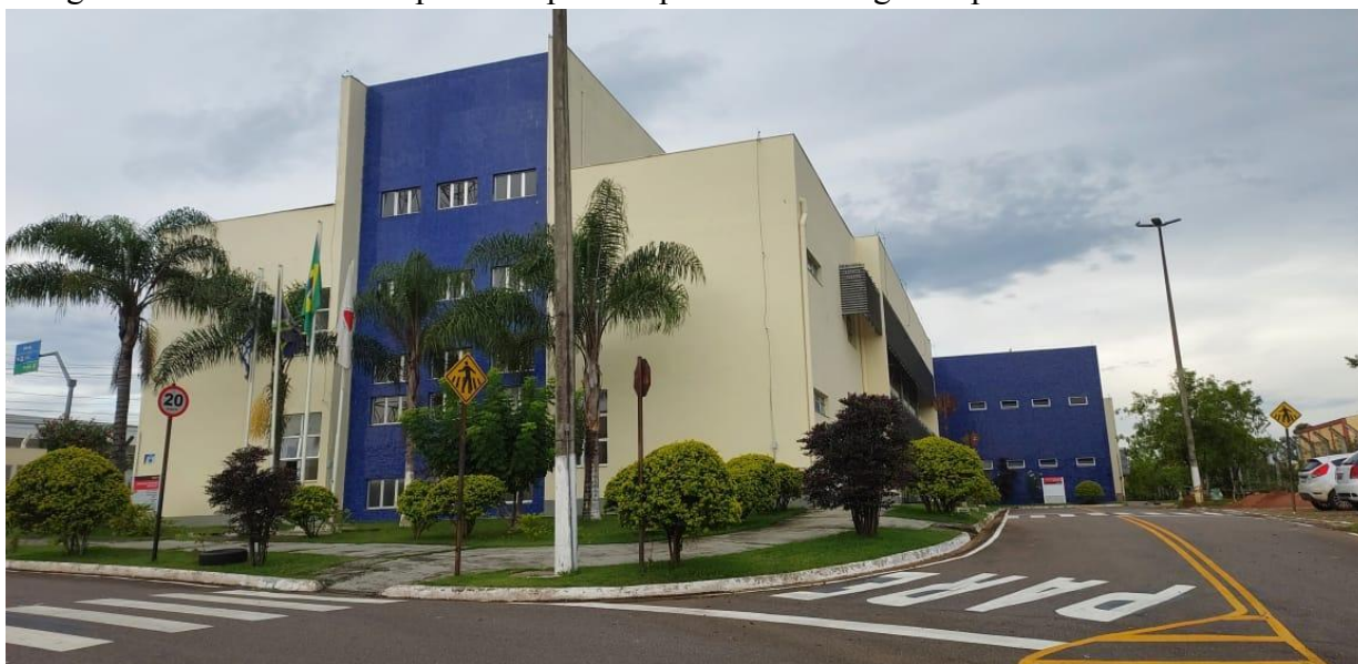
Fotografia 17 – Prédio B em primeiro plano e prédio C em segundo plano
