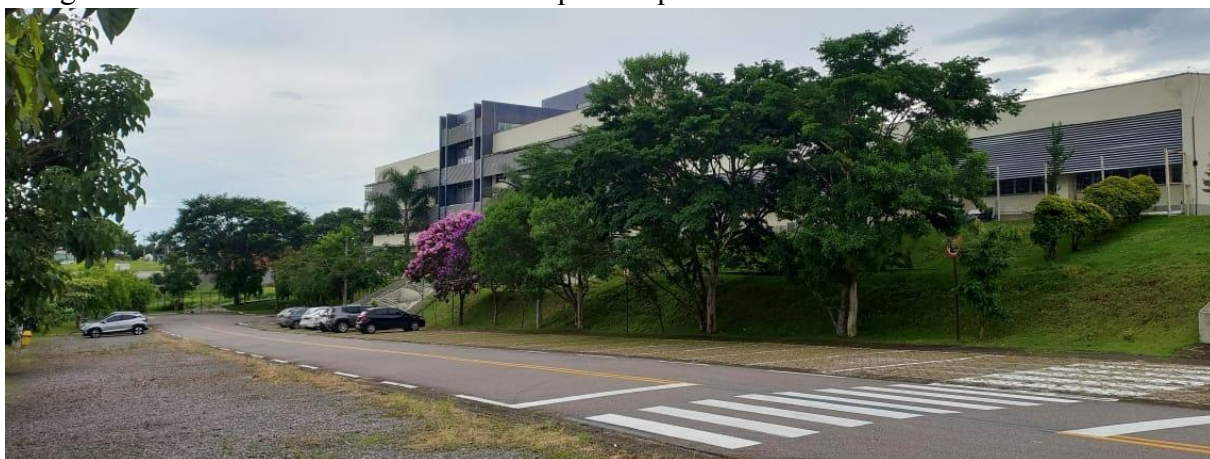
Fotografia 20 – Estacionamento com visão para os prédios A e D
