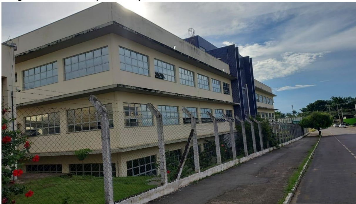
Fotografia 19 – Visão do prédio D a partir da Avenida Celina Ferreira Ottoni
