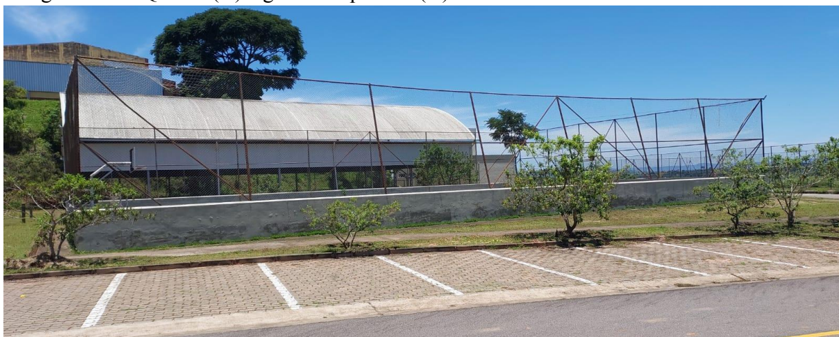
Fotografia 23 – Quadra (G) e ginásio esportivo (H)
