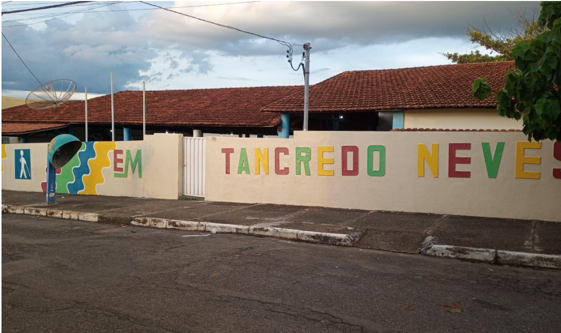
Figura 7 – Fachada da Escola Municipal Tancredo Neves
