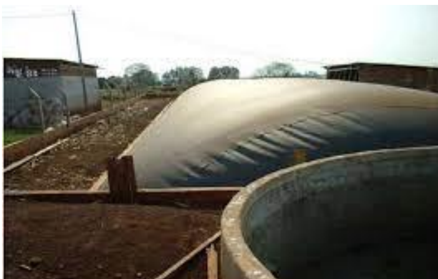
Figura 5 - Biodigestor Tubular com capacidade para 800m 3 .
