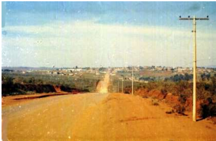
Figura 2 - Registro da Av. Governador Valadares sem pavimentação no bairro Vista Grande na década de 1960.
