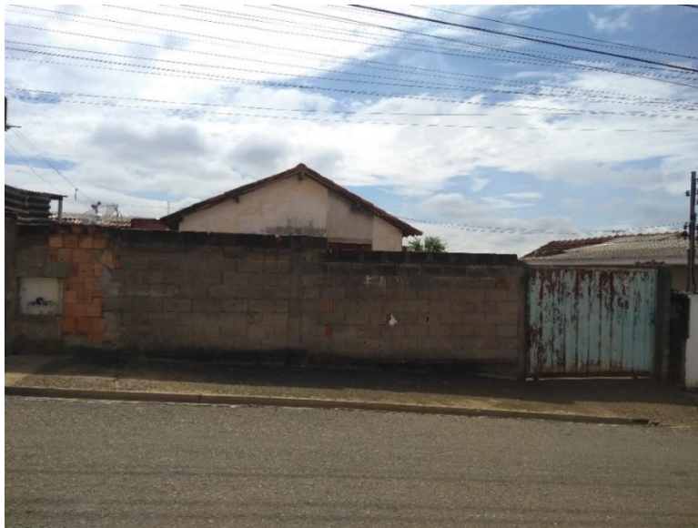
Figura 24 – Casa em construção no Pinheirinho I
