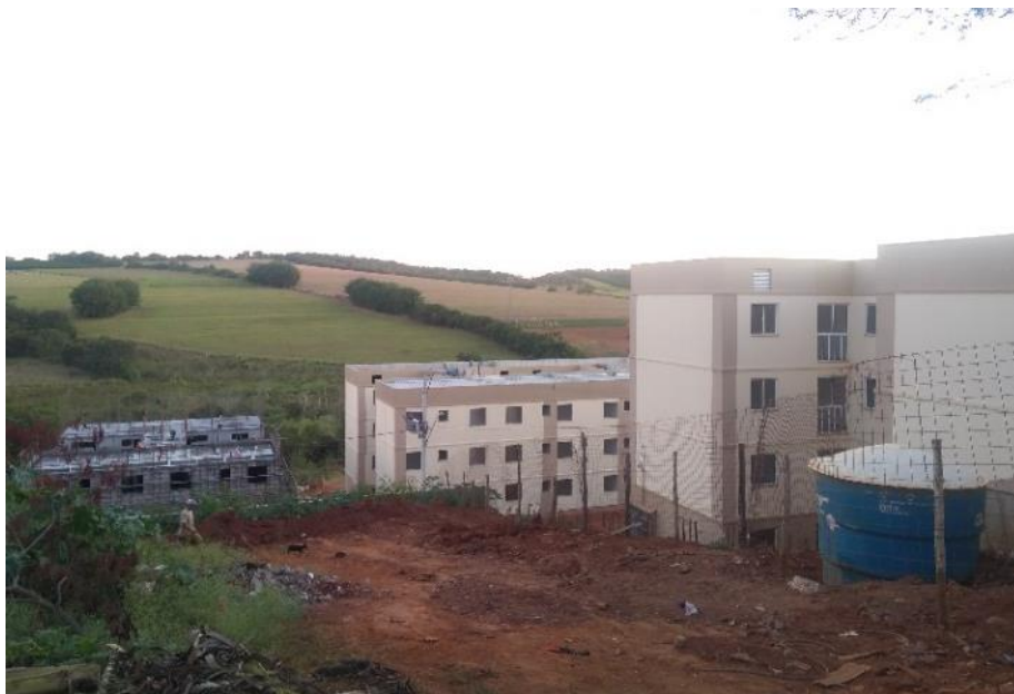
Figura 21 – Construção do Residencial Jardins de Alfenas
