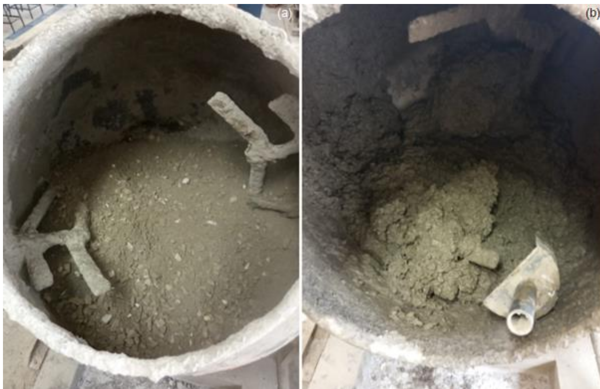
Figura 14 - Confeção do concreto em betoneira
