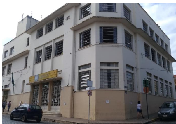
Fotografia 4– Edifício em que funciona a sede da Prefeitura Municipal da Campanha
