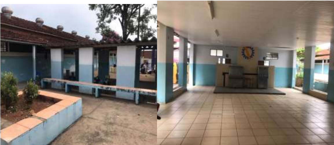
Figura 15 - Bancos na passagem e bebedouros
