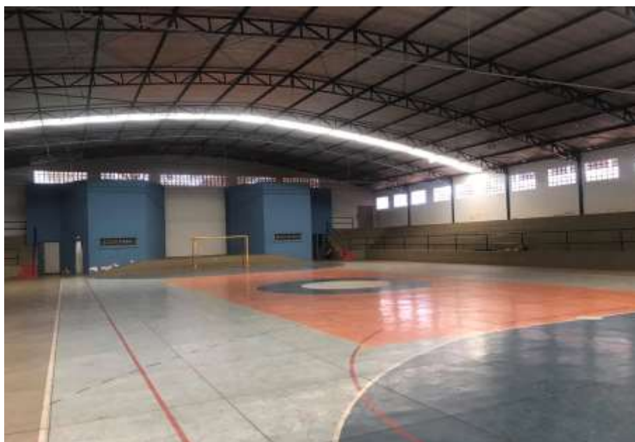
Figura 24 - Nova Quadra Poliesportiva Coberta
