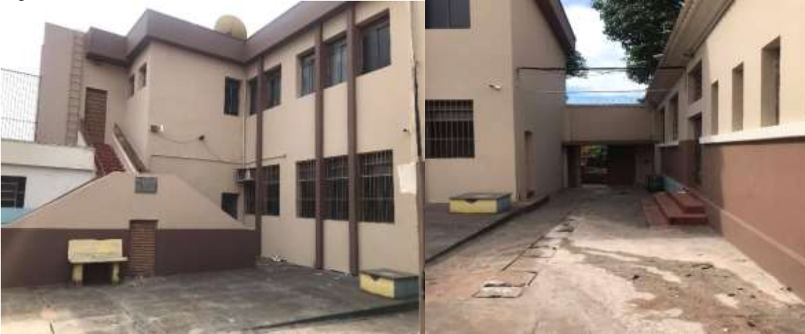
Figura 20 - Prédio anexo dos laboratórios e entrada dos alunos
