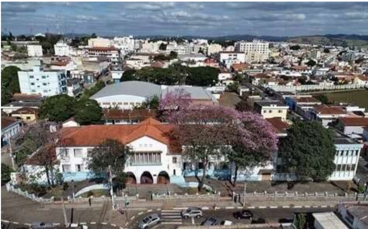
Figura 2 - Vista aérea da escola
