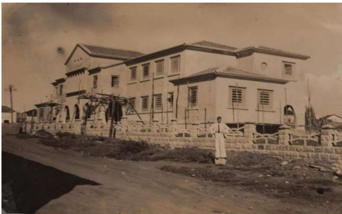
Figura 1 - Escola no período de finalização da construção
