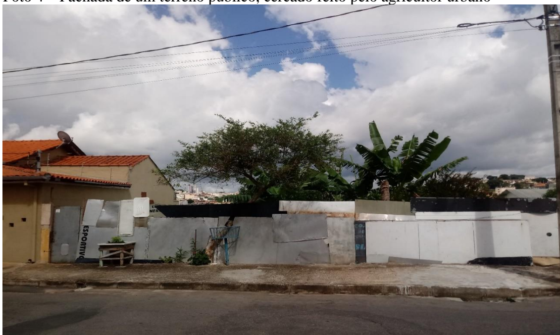
Foto 4 – Fachada de um terreno público, cercado feito pelo agricultor urbano
