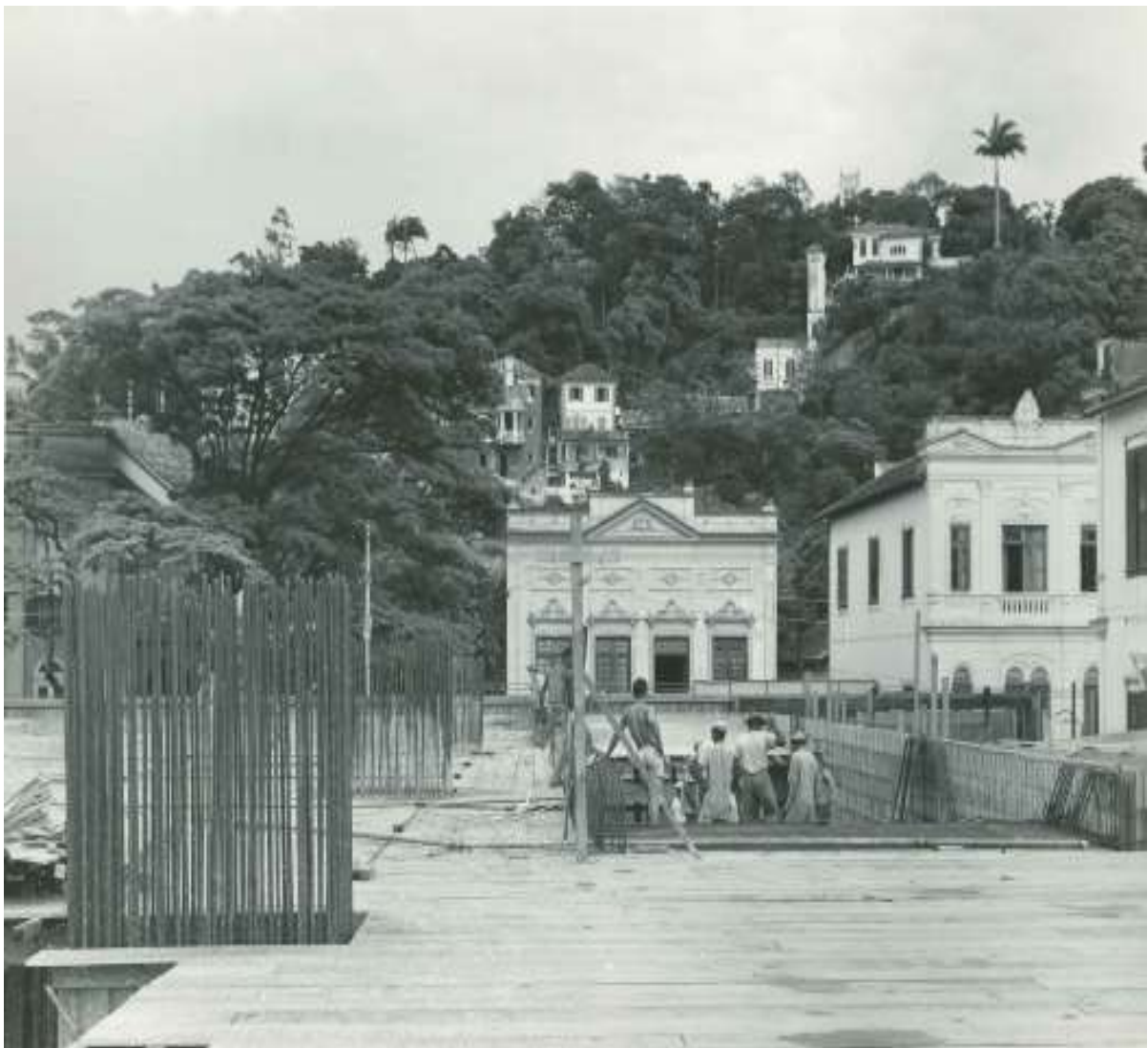
Fotografia 3 - Construção do edifício sede da Fundação Getúlio Vargas
