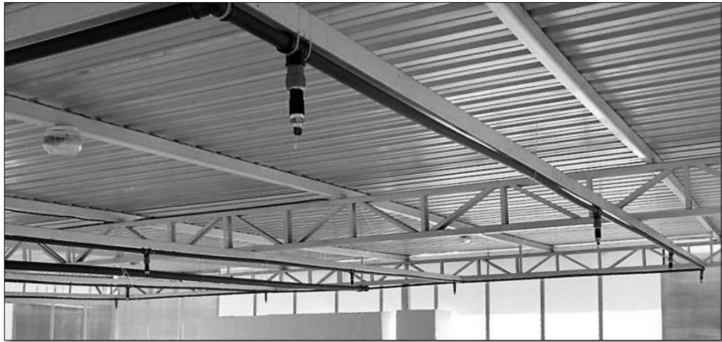
Figura 7 - Foto de bicos aspersores com sistema corta-gotas.
