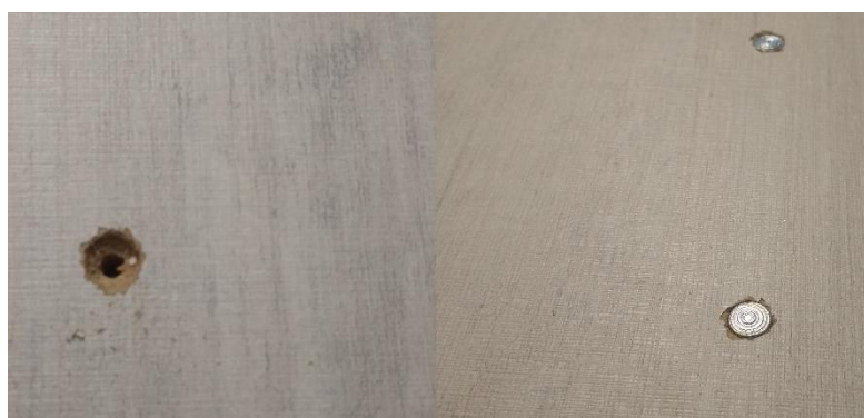
Figura 20 - Alojamento e prego colocado e alinhado
