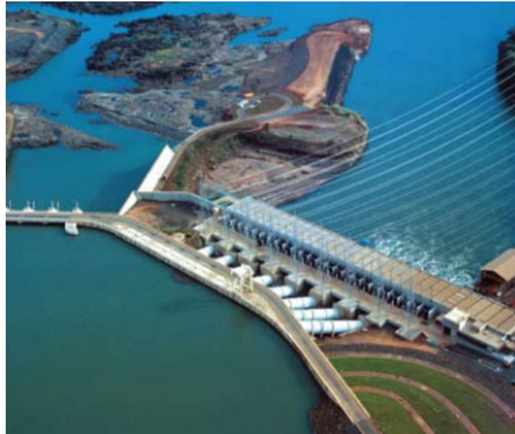
Figura 1 – Usina hidrelétrica de Marimbondo.
