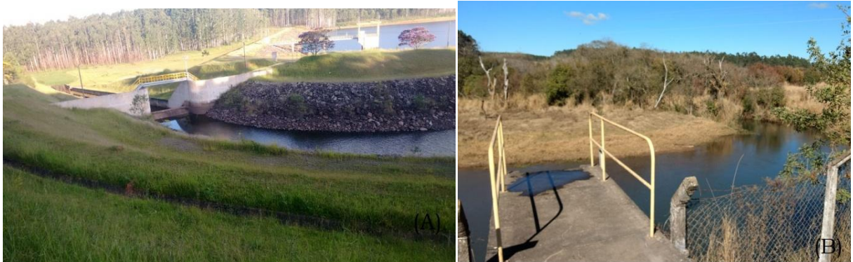
Figura 10- Manancial Cipó: (A) Represa do Cipó; (B) Ribeirão Cipó na captação.
