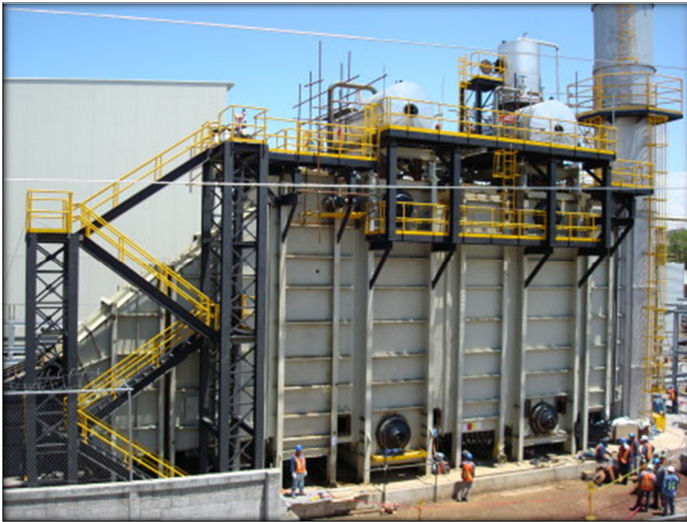
Figura 14 - Caldeira de recuperação de calor sendo montada. Fonte:(INDUSTRIALACCESS, 2015).
